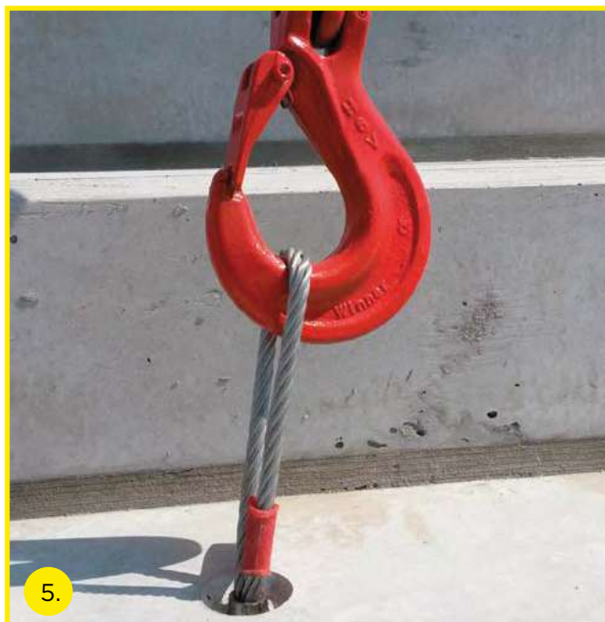
A lépcső emelése a beépített dübel és az emelőfülek segítségével
