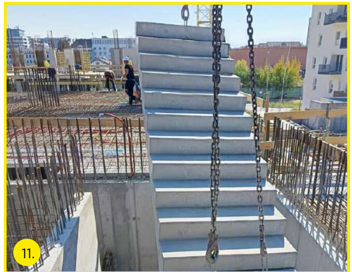
Méretre gyártott betonlépcső beemelése
